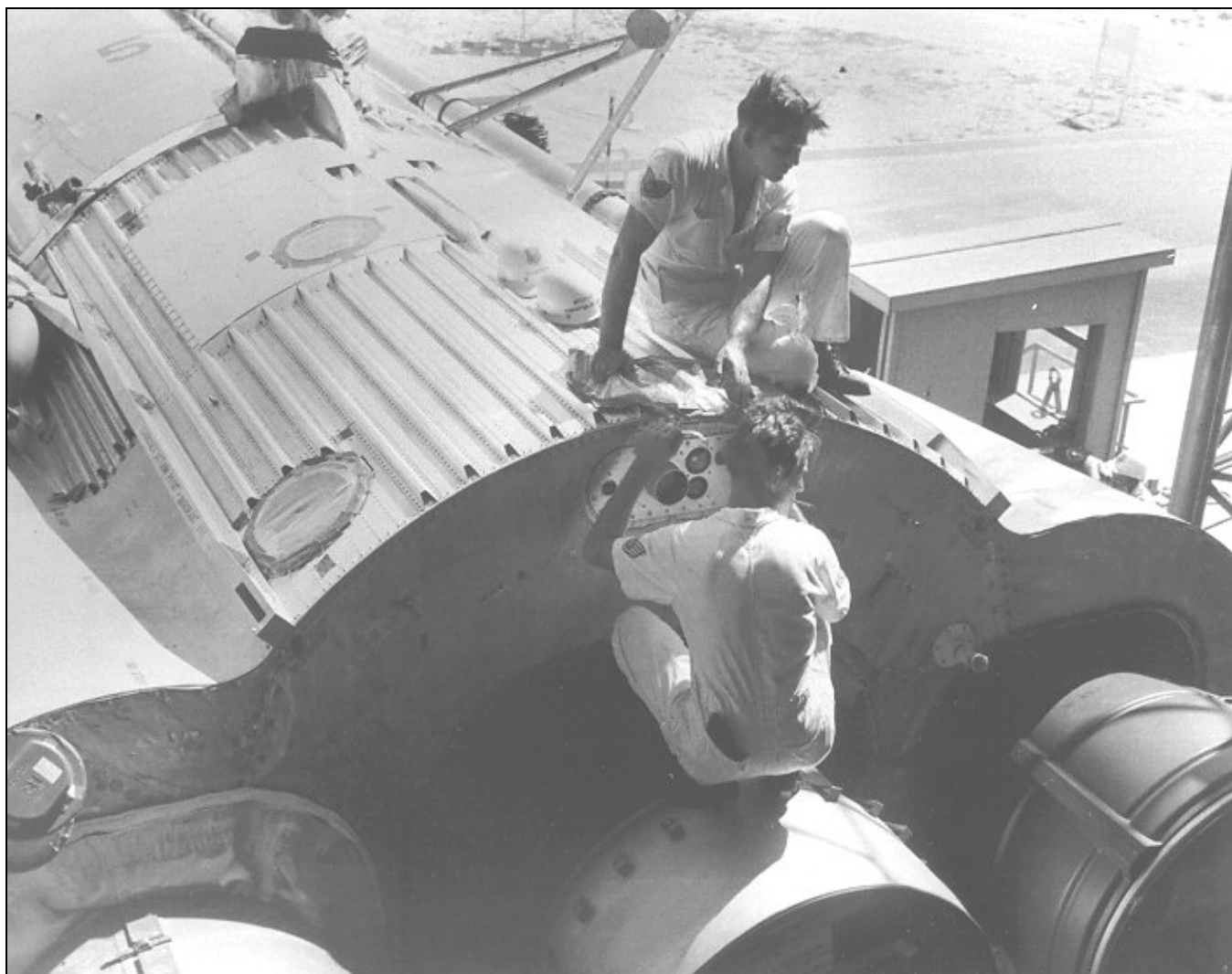
Příprava na usazení rakety Atlas F (#5F?) na startovací rampu.
